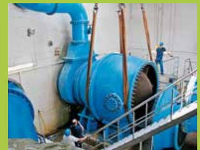
Das Ringkolbenventil DN 2000 wurde im August 2009 bei ERHARD generalüberholt, nachdem die Armatur seit Inbetriebnahme der Talsperre im 1967 ununterbrochen funktionierte.
