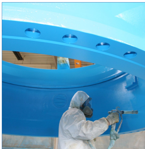
EKB-BESCHICHTUNG IM ERHARD-WERK IN HEIDENHEIM/DEUTSCHLAND
