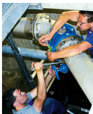
AUSTAUSCH EINES ABSPERRSCHIEBERS DURCH EINE ABSPERRKLAPPE MIT LOSFLANSCH
