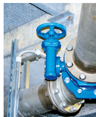
ARMATUR KANN NACH EINBAU IN DIE FINALE POSITION GEDREHT WERDEN
