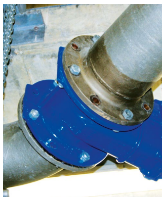
AUSTAUSCH EINES ABSPERRSCHIEBERS DURCH EINE ABSPERRKLAPPE MIT LOSFLANSCH
